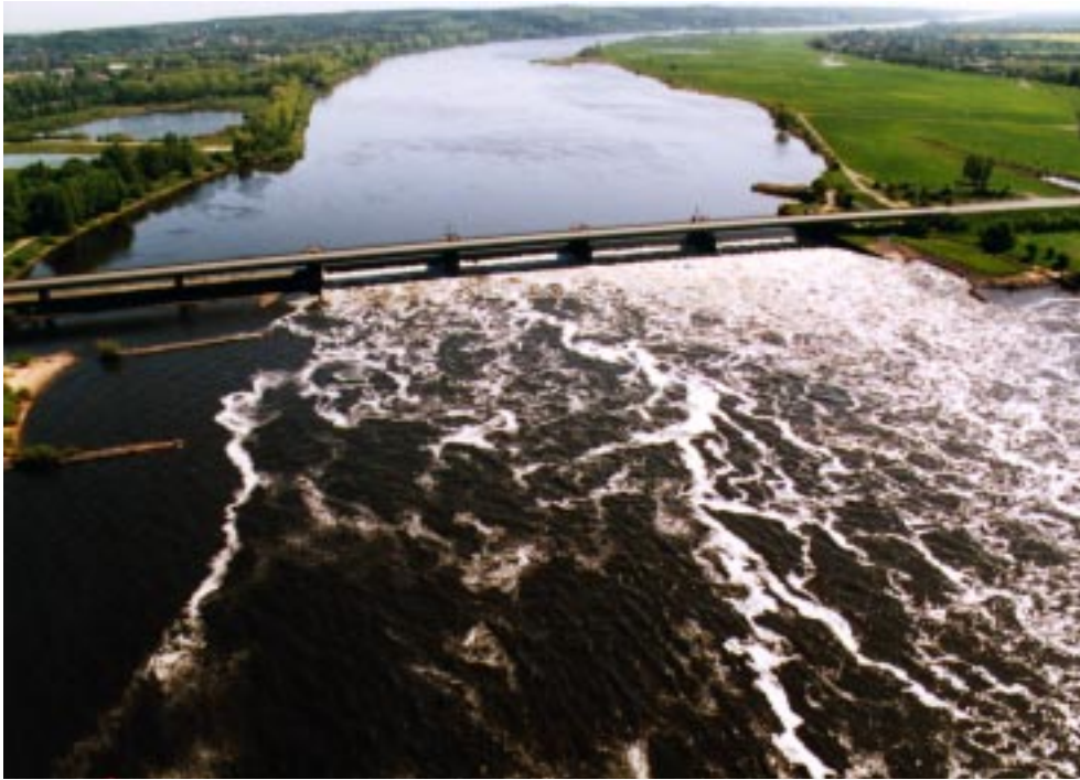
Abb. 2.19: Die einzige Staustufe auf deutschem Gebiet: das Wehr Geesthacht; unterhalb dieses Wehrs beginnt die Tide-beeinflußte Zone der Elbe. Am rechten Bildrand ist die alte Fischaufstiegstreppe zu erkennen (Elbe-km 586).
